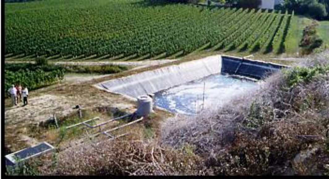
Figure 4 : Exemple de traitement de finition par lit planté de roseaux
