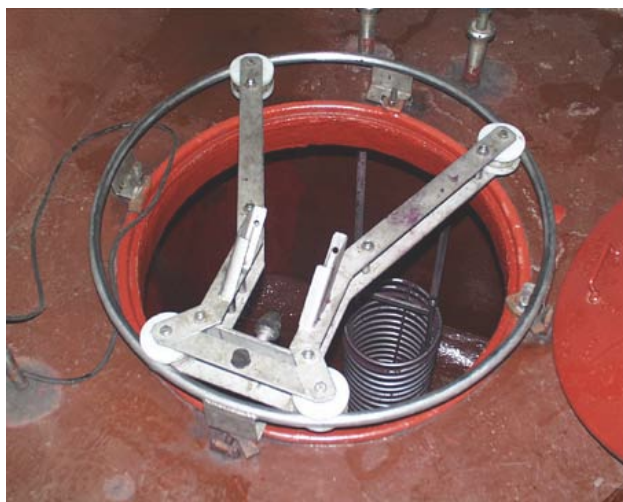
photo 3 : Couronne cylindrique solidaire de la cuve
